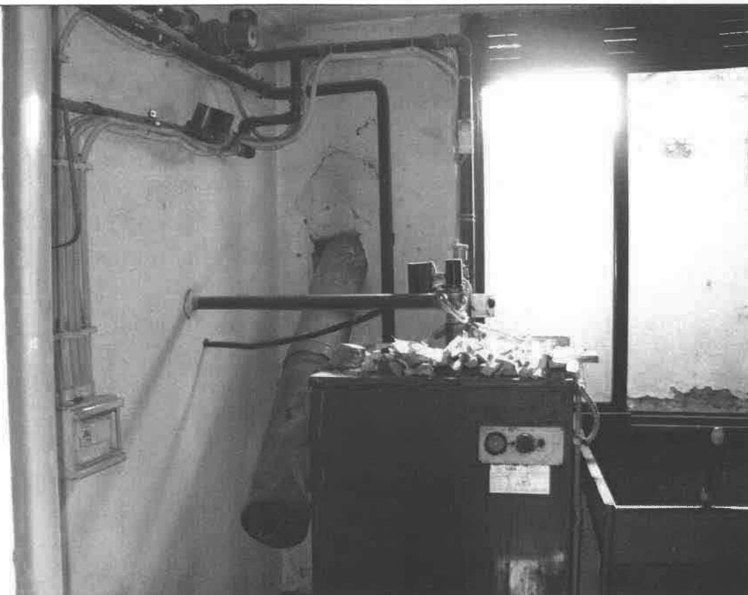
Foto 23): Magazzino - Foglio 43 part.191 sub.6 (Locale caldaia)
